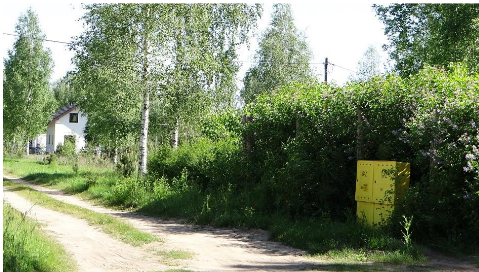
Zdjęcie nr 3. Obszar opracowania – zabudowa mieszkaniowa i infrastruktura (zaopatrzenie w gaz).
