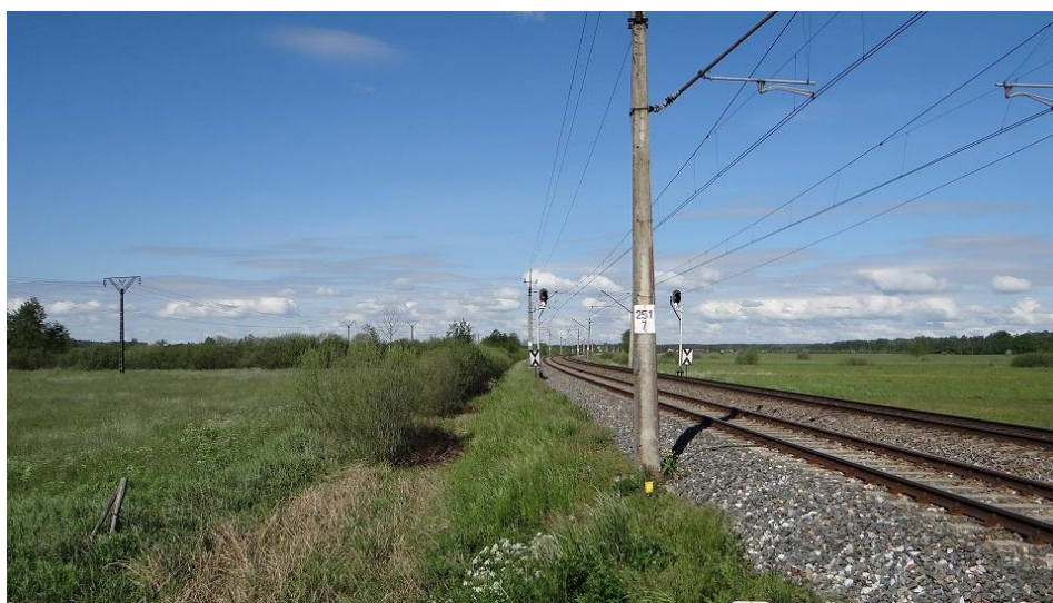
Zdjęcie nr 6. Obszar opracowania – bezpośrednie sąsiedztwo – linia kolejowa nr 353 relacji Poznań Wschód - Skandawa.
